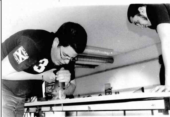
Installation du mur d'escalade lors d'un chantier en soirée avec les résidents
